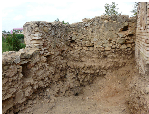
Figura 19. Àrea on s'ha efectuat l'excavació-sondeig.
