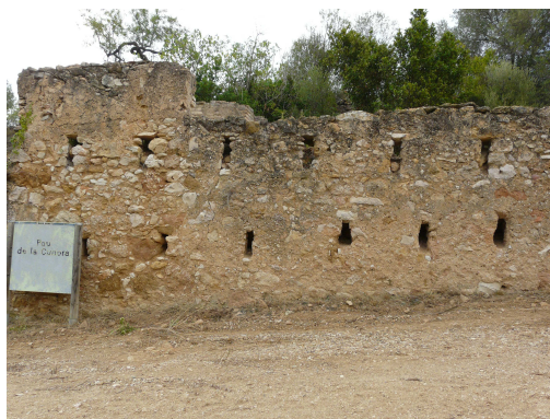
Figura 11. Exterior del mur perimetral de tanca.
