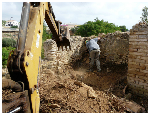
Figura. 10. Excavació amb màquina sota control de l'arqueòleg.
