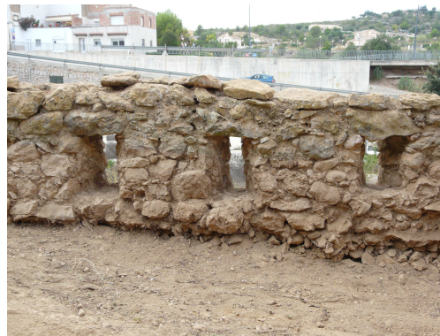
Figura 13. Interior del mur perimetral de tanca.
