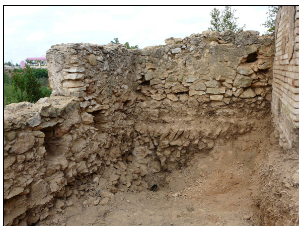
Figura 16. Base irregular de la cara interior del lateral nord del mur de tancament.
