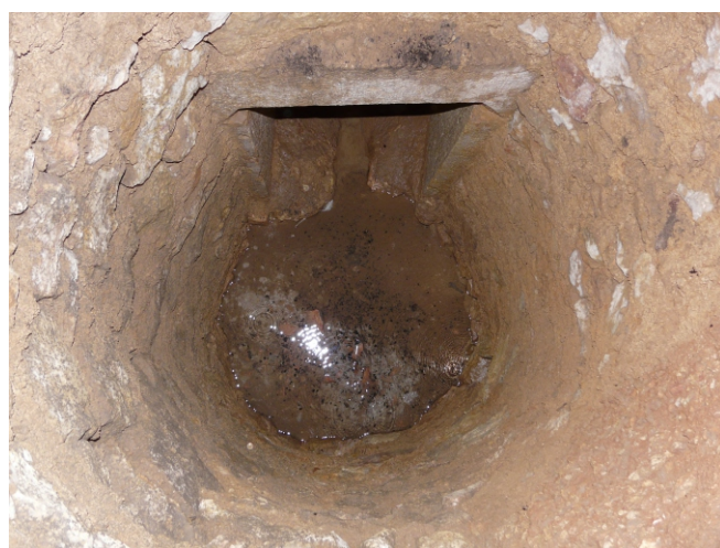
Interior del pou
