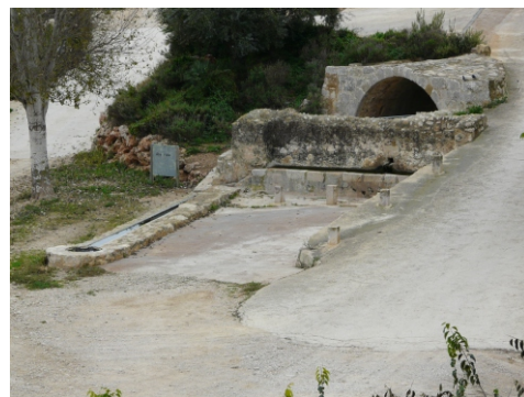
Vista del conjunt
