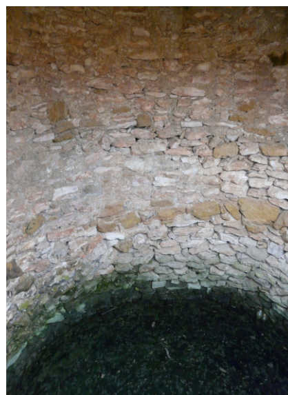
Interior del pou
