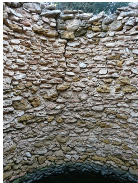
Interior del pou
