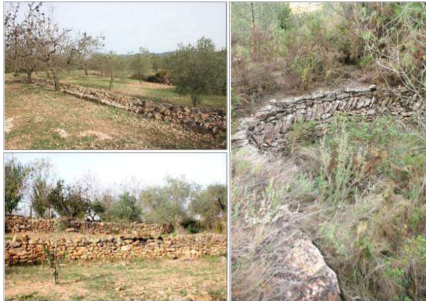
Fotos. Mur de pedra seca distribuïts arreu de la finca. Marges dels camp d'oliveres i ametllers de la meitat nord de l'àmbit d'estudi (dalt esquerra), murs de l'extrem sud-est, sota la zona enjardinada (baix esquerra) i marges semicirculars construïts al barranc secundari de l'est de la parcel·la (dreta)
