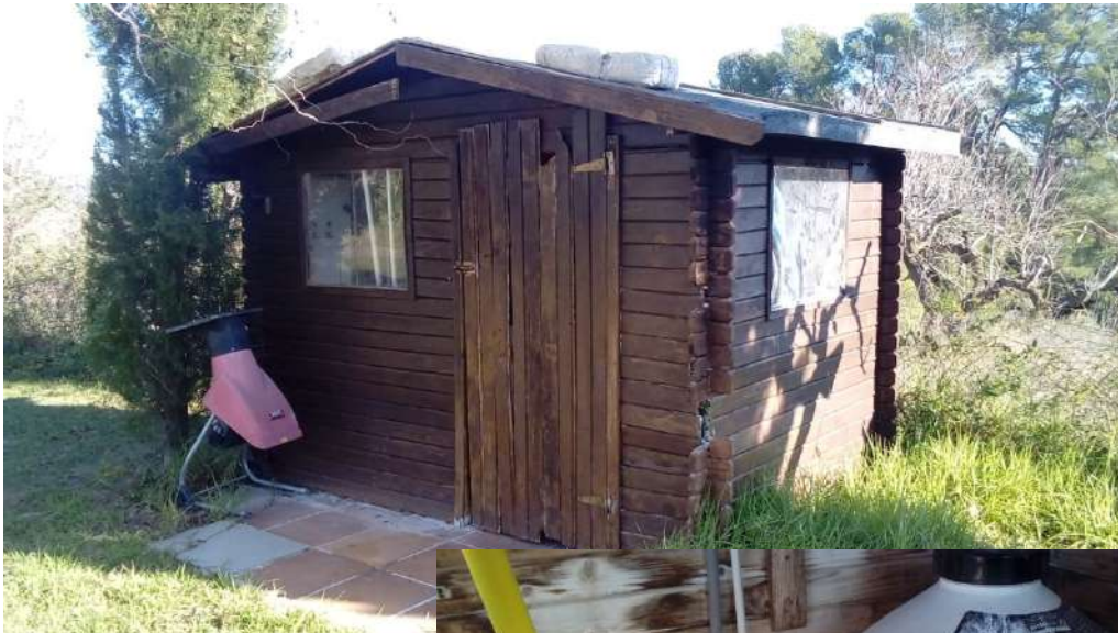
Magatzem 4 Depuradora piscina
