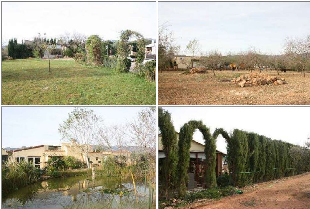
Fotos. Visuals de les edificacions existents: vista des de l'E (dalt esquerra), des del N (dalt dreta), des de la zona enjardinada al N de l'edificació principal (baix esquerra) i des del camí d'accés, al S (baix dreta).
