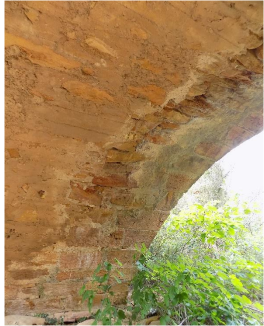
Imatge 11. Pont de Sant Salvador.
