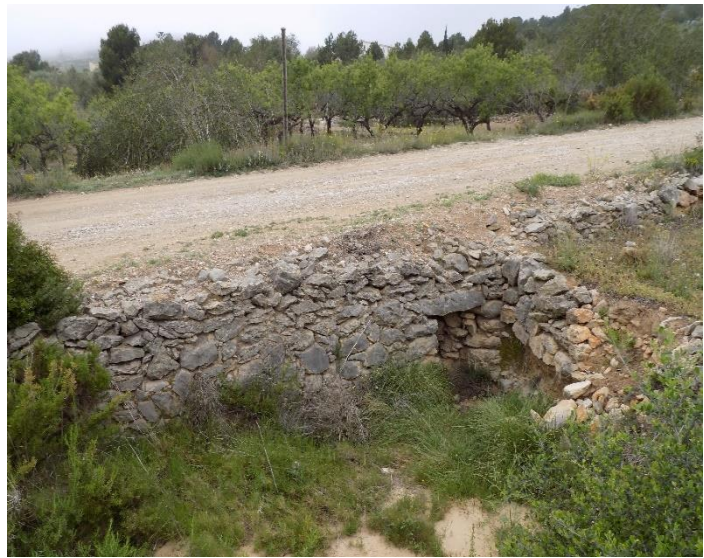
Imatge 10. Fotografia des d'un lateral del Tram III, es pot apreciar el desguàs amb dintell.
