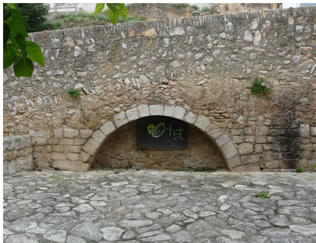
Figura 26. Vista frontal de la font de la Panavera.
