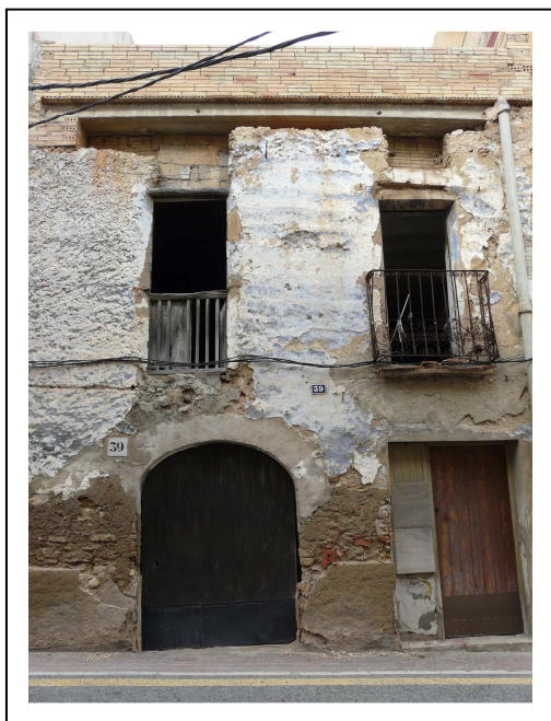
Cal Bou, estat actual
