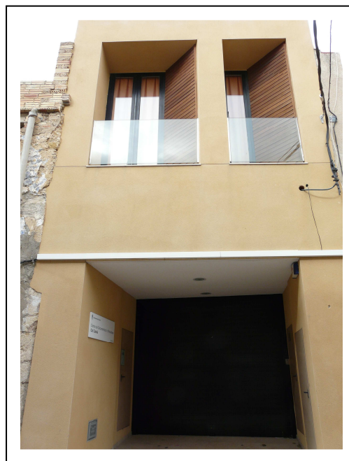
Cal Català, estat actual
