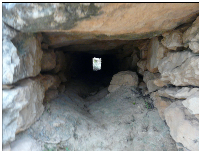
Fotografia de l'interior del desguàs, al tram 2
